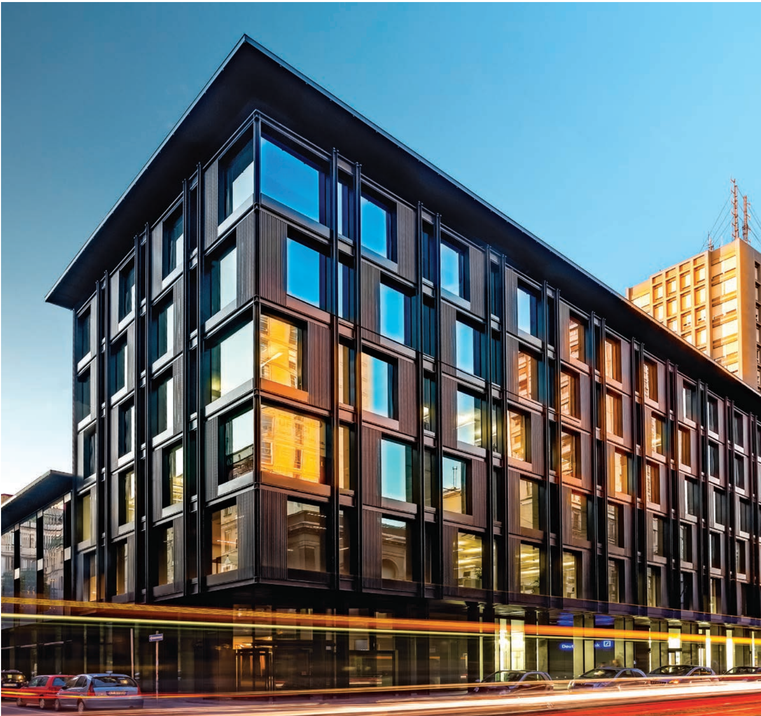
Sede di Milano Turati
